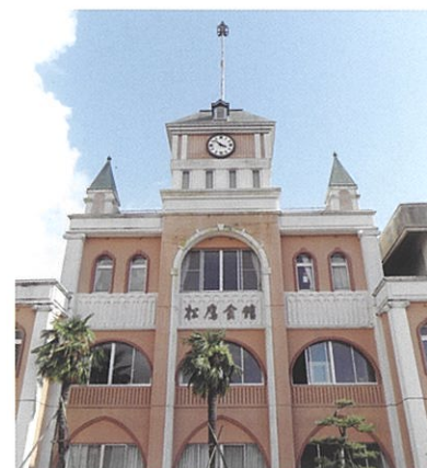
しょうようかいかん 松鷹会館（同窓会館）
